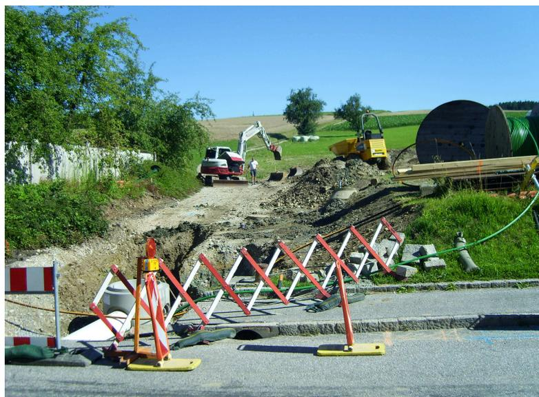
Zur Einmündung des neuen Regenwasserkanales in den Roßbach ist die Querung der Landesstraße erforderlich. Auf dem Foto der Schachtbau zur Querung in den Roßbach.
